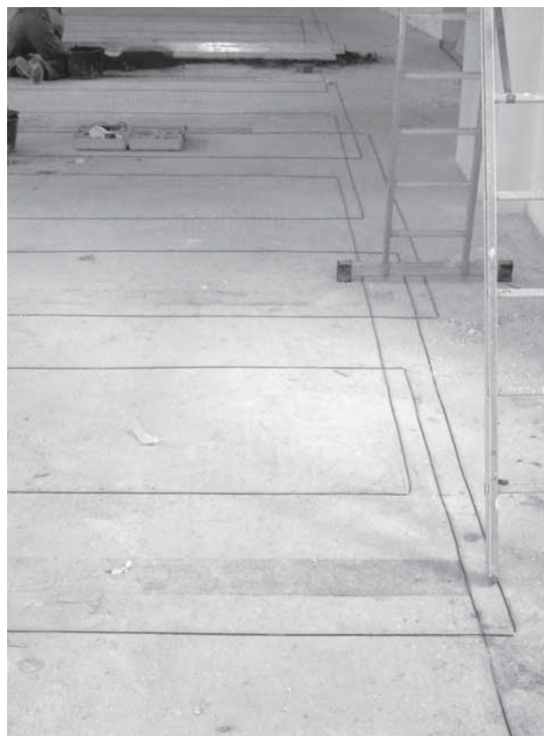
Verlegung der Höranlage in der Kreuzkirche Dresden
